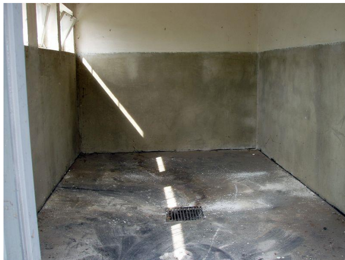
Obr. 12: Podlaha skladu se záchytnou jímkou
