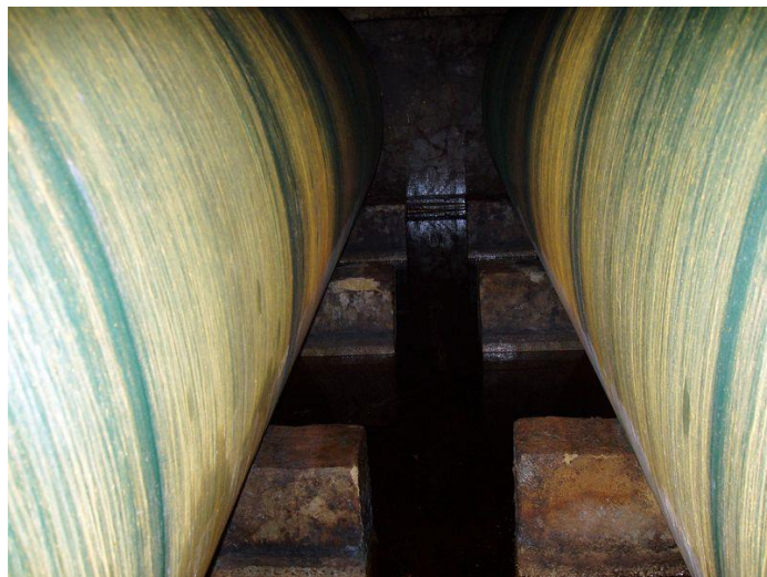
Obr. 8: Uložení nádrží v záchytné jímce
